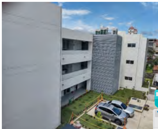
Fachada interior actual Sede Despachos Judiciales Guamo - Tolima
