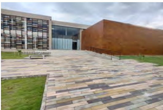
Fachada actual Sede Judicial Los Patios - Norte de Santander
